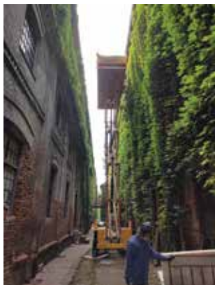
9. Evakuacija tavanskih prostora vanjskom dizalicom. (Fototeka Gliptoteke HAZU) Evacuation of attic space using external crane. (HAZU Glyptothèque photo files)
