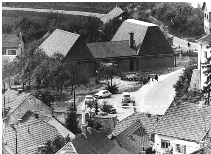
2. Zgrada Galerije Antuna Augustinčića snimljena 1. svibnja 1976. (arhiva GAA)
