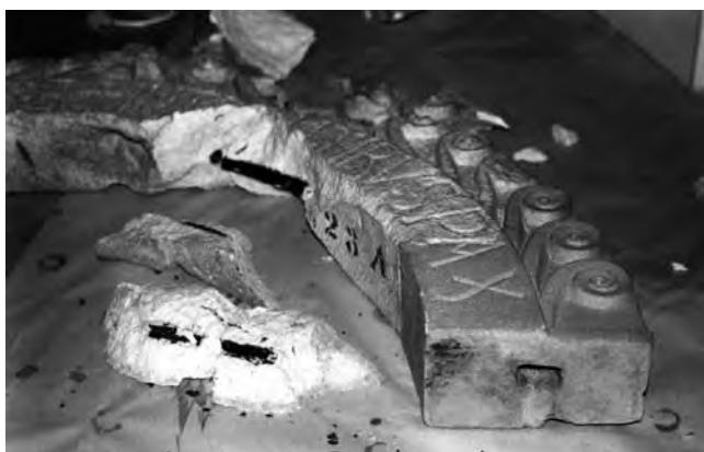
2. Oštećenje luka uslijed korozije željeznih trnova
